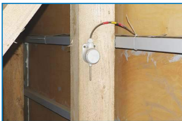
Датчик температуры воздуха, установленный в вентиляционном канале системы VENTOGLAS™.
