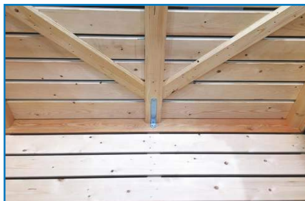
Пол контейнера выполнен из доски 25 мм.
