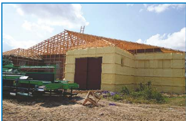
Утепление ППУ снаружи реконструированного хранилища.
