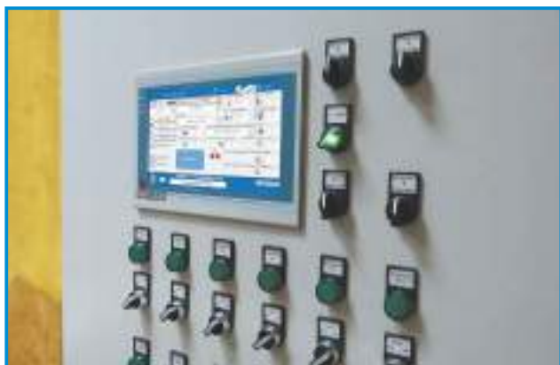
Сенсорный контроллер с интернет-модулем VENTOGLAS™ передаёт визуализацию через сеть Интернет.
