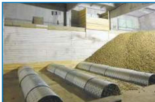
Овощехранилище навалального типа хранения с активной вентиляцией продукции.
