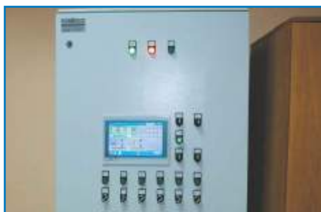
Блок VENTOGLAS™ управляющий вентиляционной системой – сушильной стеной прямого действия.
