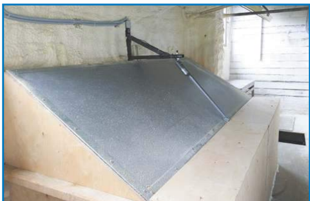
Вокруг приточного клапана монтируется камера смешивания. Полностью открытый клапан забирает только уличный воздух.
