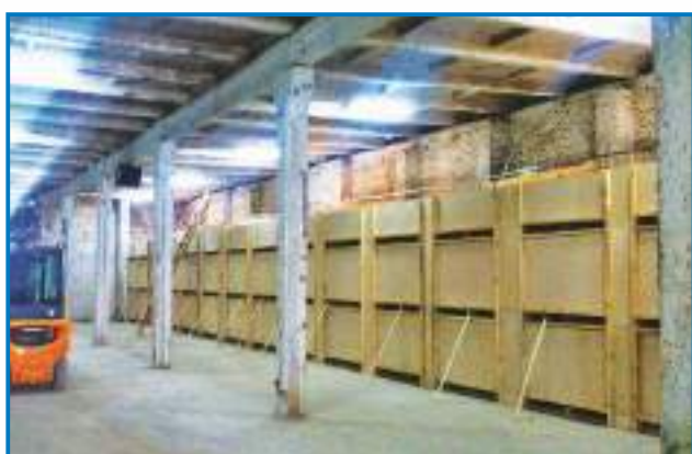
Картофелехранилище оборудованное стеной прямого действия. Хорошо видны щели, через которые будет продуваться воздух.
