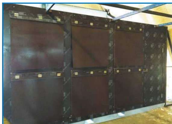
Обратные клапаны Ventoglas™ вертикального типа.
