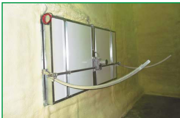
Выбросной клапан AgroVent® с редуктором и обогревателем уплотнителя. Изготовлен в Голландии.
