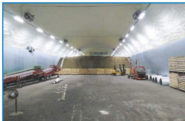
Овощехранилище навалного типа с поперечным расположением напольных вентканалов.
