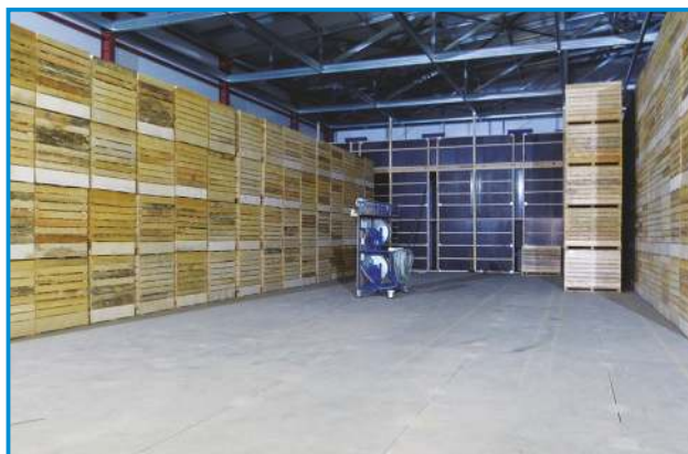
Сушильная стена обратного действия, которая управляется компьютерной автоматикой VENTOGLAS™.
