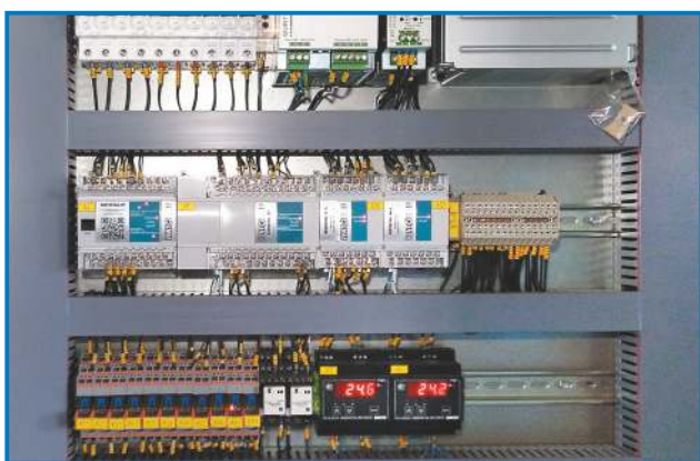
Блок управления VENTOGLAS™ соответствует всем требованиям монтажа и электробезопасности.
