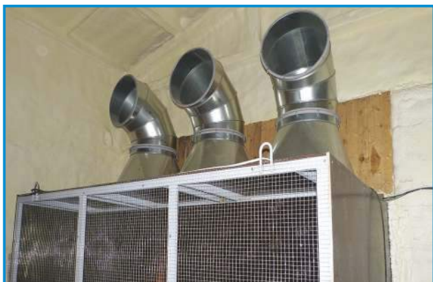
Модуль VENTOGLAS™ с направленными воздуховодами в хранилище, с общеобменной (пространственной) вентиляцией.
