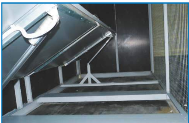
Полностью открытый приточный клапан МВК для контейнерного хранения, обеспечивает отбор воздуха только с улицы.
