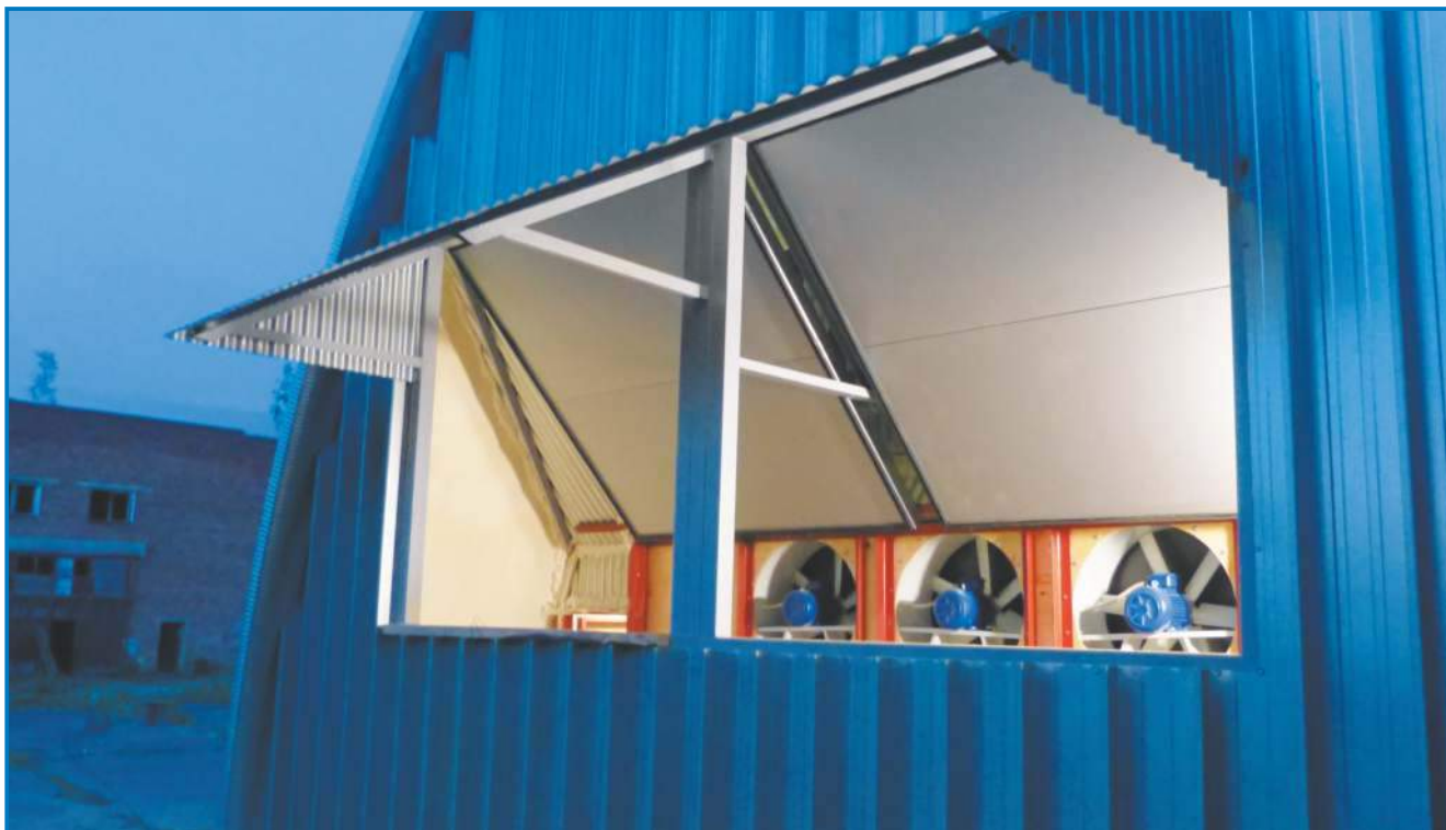
Овощехранилище с установленной вентиляционно-климатической системой VENTOGLAS™.
