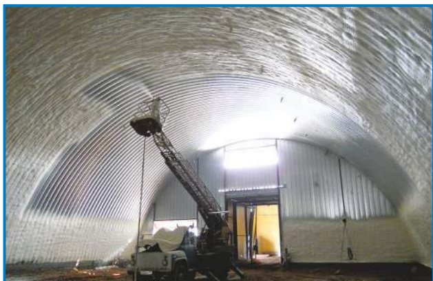
Утепление хранилища пенополиуретаном осуществляется с помощью лесов или автовышки.
