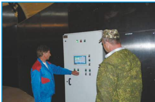
Главный специалист компании проводит обучение работе с вентиляционной системой VENTOGLAS™.
