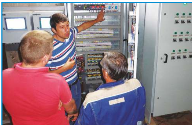
Обучение работе с системой VENTOGLAS™ проходит непосредственно на месте установки вентиляции.
