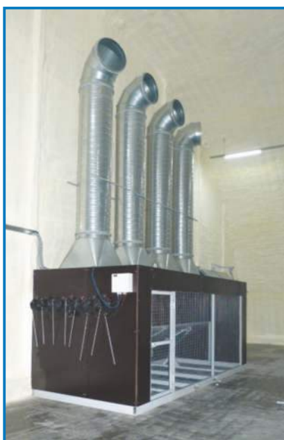
Модульная венткамера VENTOGLAS™ с блоком датчиков на боковой стене.
