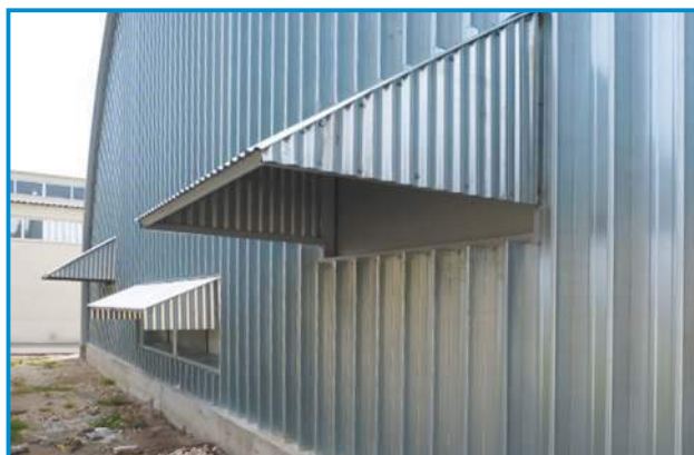
Снаружи все клапаны в овощехранилище контейнерного типа защищены козырьками из перфорированного стального листа.
