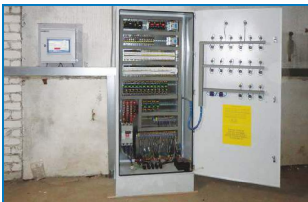
Блок управления VENTOGLAS 12P3 с вынесенной сенсорной панелью управления.
