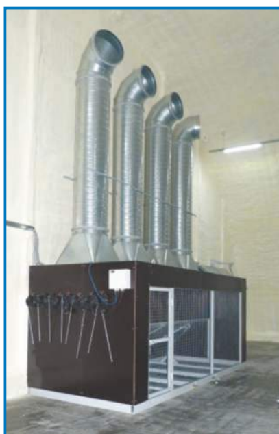
МВК для общеобменной вентиляции в контейнерном овощехранилище с размещённым сбоку Блоком датчиков.
