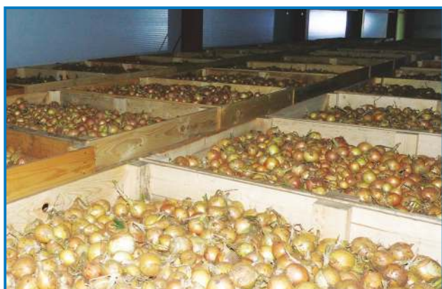
Контейнеры установлены, осталось положить содержащую мембрану и включить систему вентиляции.
