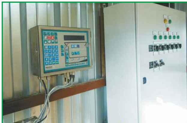
Блок ручного управления и компьютер AgroVent изготовлен в Голландии
