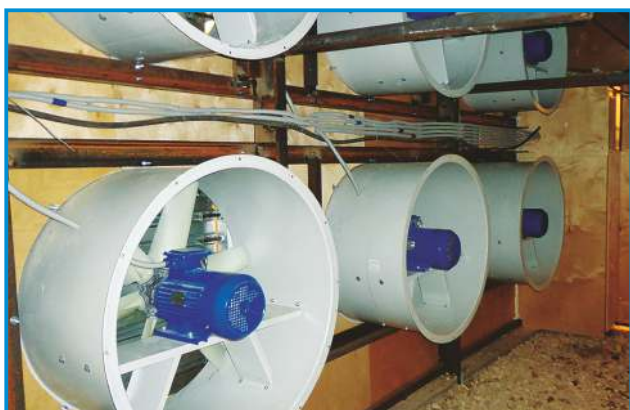
Напорные вентиляторы VENTOGLAS. Его лопасти изготовлены из композитных материалов. Произведён в России.
