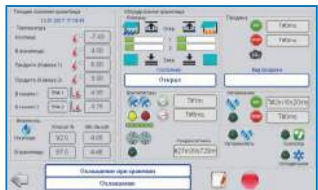
Компьютер VENTOGLAS™, по запросу пользователя, выводит на экран текущее состояние процессов в хранилище.
