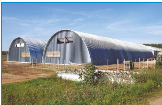
В этом картофелехранилище установлена система VENTOGLAS.
