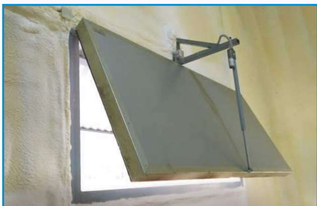
Выбросной клапан VENTOGLAS™ с актуатором и подогревом уплотнителя. Клапан произведён в России.
