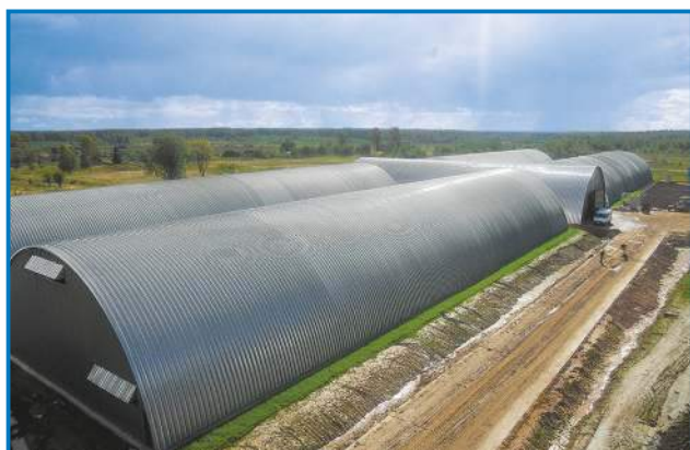
Построенный компанией «ППУ XXI ВЕК» комплекс по хранению и переработке картофеля.
